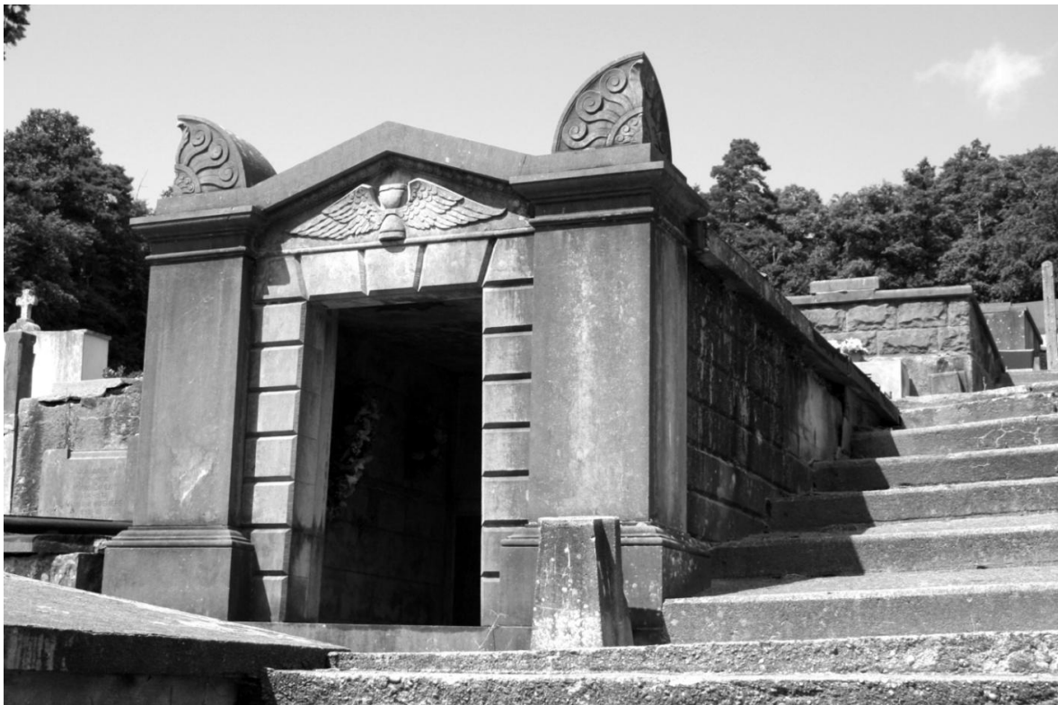
Fig. 7 Mausoleum half in de helling gebouwd
